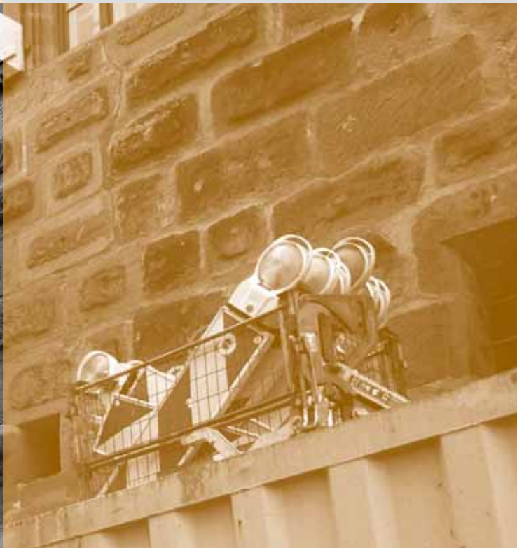
Um den Sinwellturm wird bis Mitte Juli renoviert sein.
